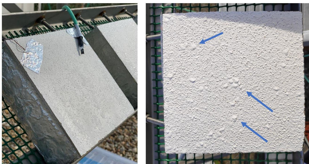
Figura 36: Registo fotográfico da condensação superficial visível no provete S2 da estação de envelhecimento da FCT/UNL.
