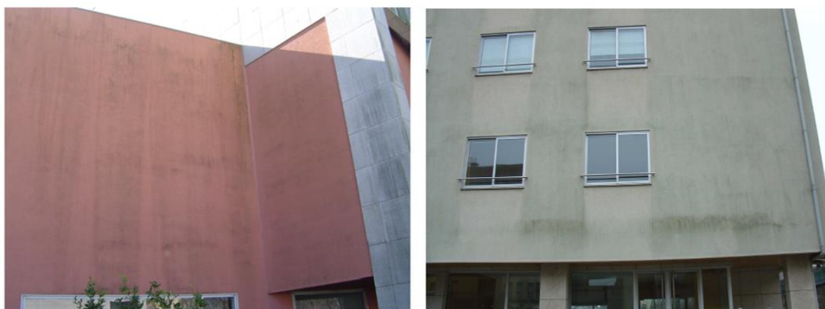
Figura 9: Desenvolvimento biológico em fachadas do tipo ETICS [3].
