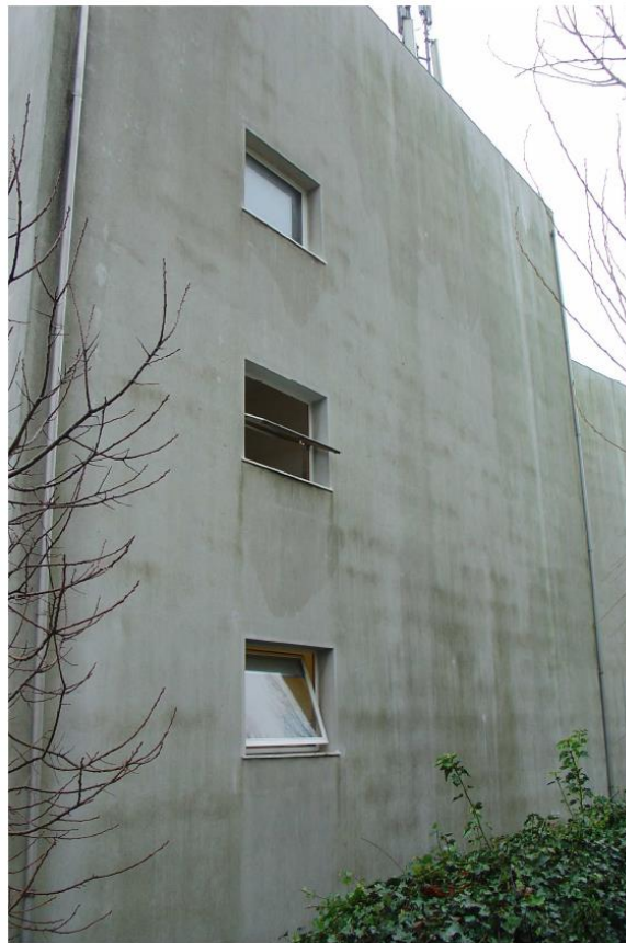
Figura 8: Desenvolvimento biológico em fachadas do tipo ETICS [3].
